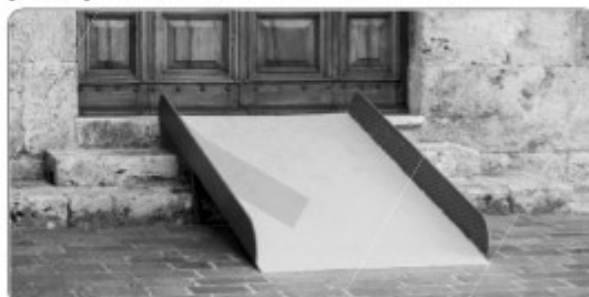
Doc. 2 Rampe d'accès à un restaurant pour personne à mobilité réduite
