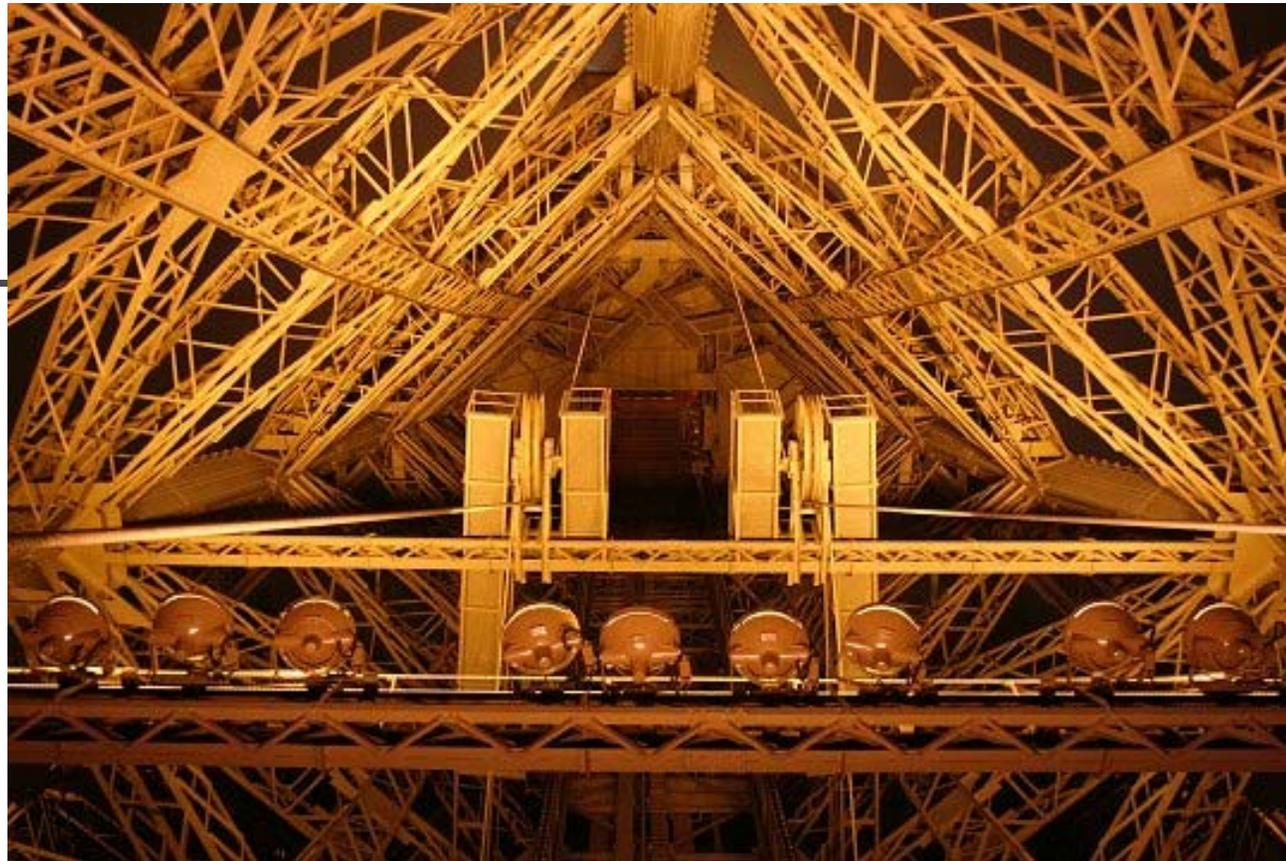
Pour monter au 3ème étage, situé 160 mètres plus haut, on est obligé de changer d'ascenseur car la longueur du piston hydraulique qui actionne ceux des étages inférieurs n'est plus suffisante.
